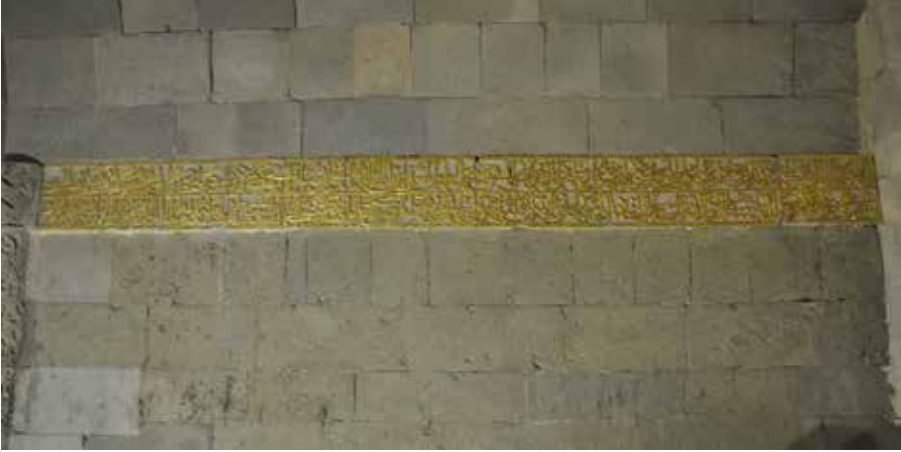
Foto. No.: 4 Doğu Duvarı Vakfiye
